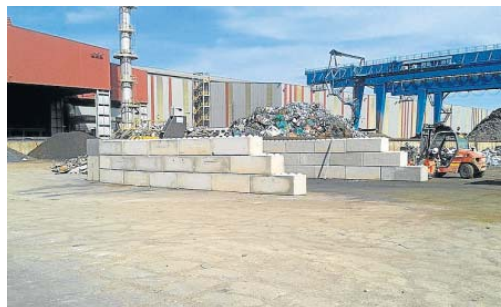
Este sistema de construcción en bloques reduce la cantidad de materiales y el impacto medioambiental final de la obra.
